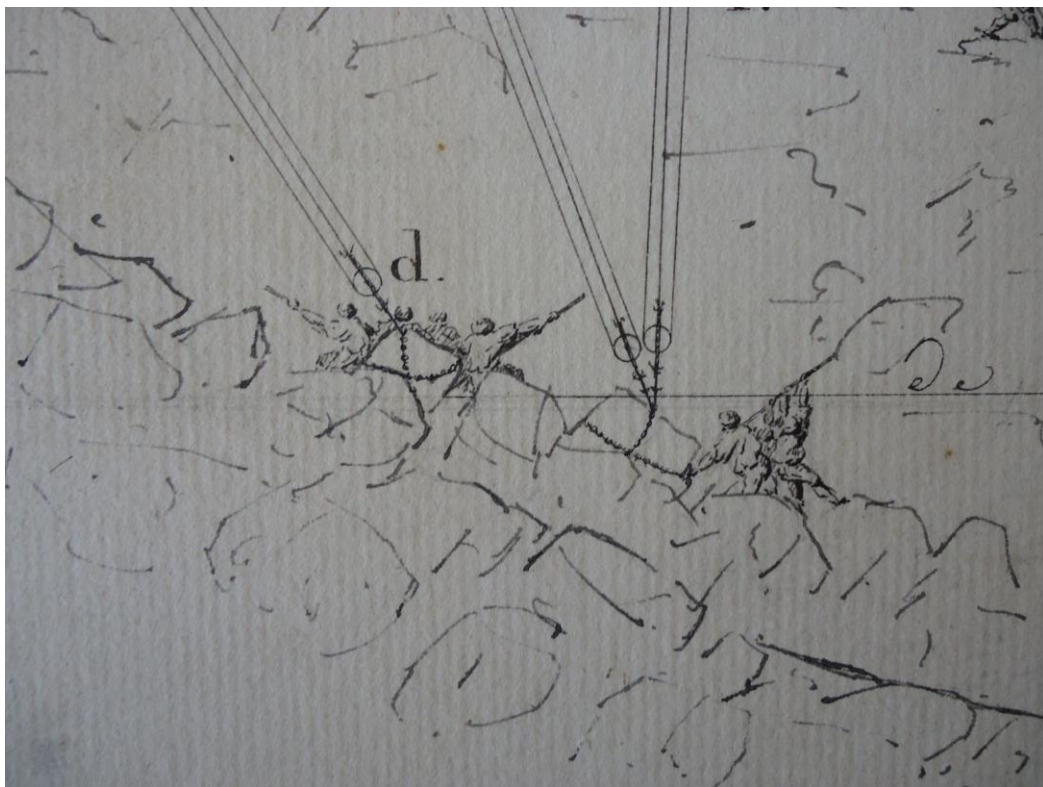
Fig. 8 : Détail qui montre les efforts importants que devaient fournir les ouvriers.
